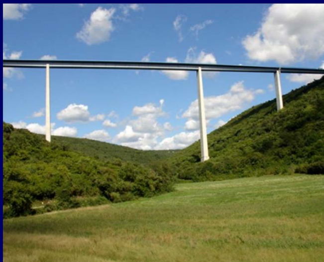
Vijadukt Limska Draga, (1988-1991)
