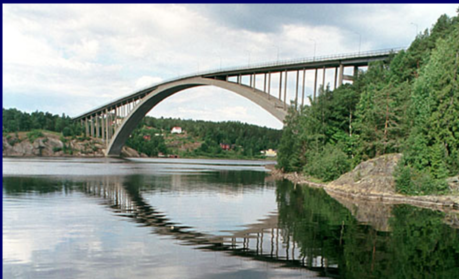
most Sandö u Švedskoj, (1943), raspon L=264\text{m}
