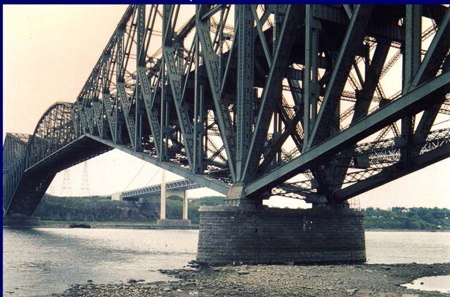
most Quebec , Kanada (1917), rekordni raspon L=549\text{m}
