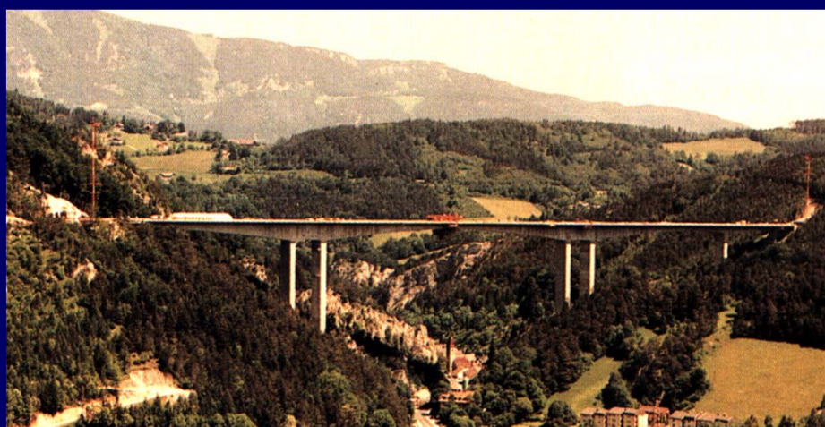
most Schottwien , Austrija (1989), raspon L=250\text{m}
