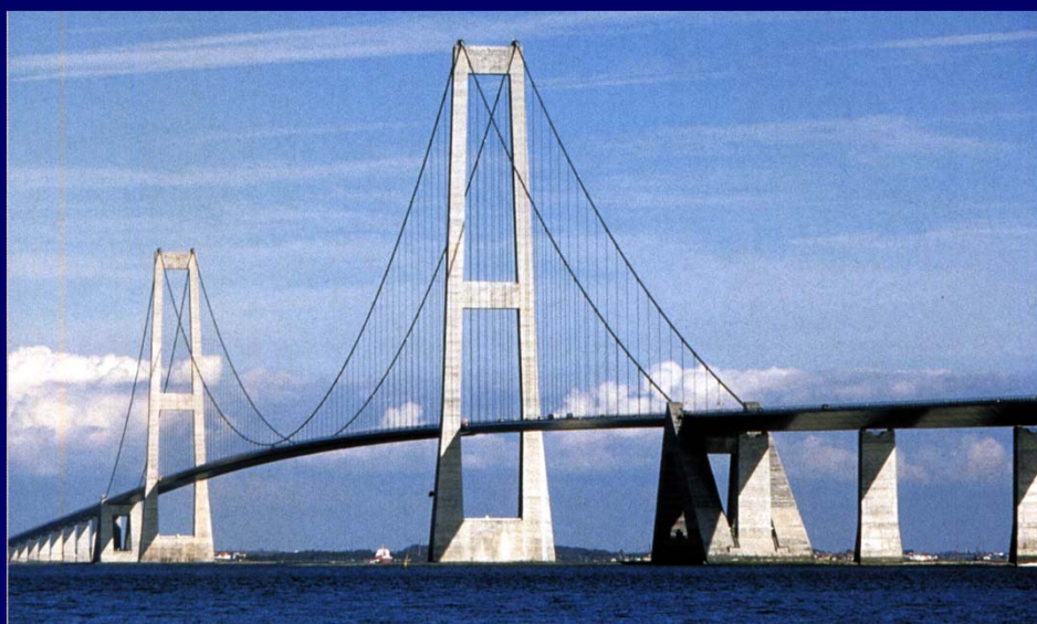
most Storebælt , Danska (1998), raspon L=1.624\text{m}
