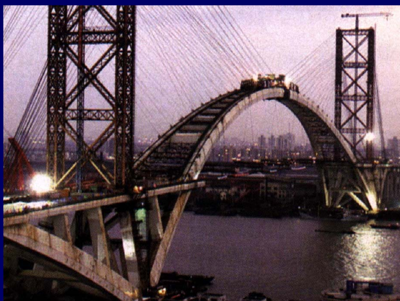
završna faza (u prosincu 2002.g.) spajanja metalnog luka rekordnog raspona L=550\text{m} mosta Lu Pu u Šangaju (Kina)
